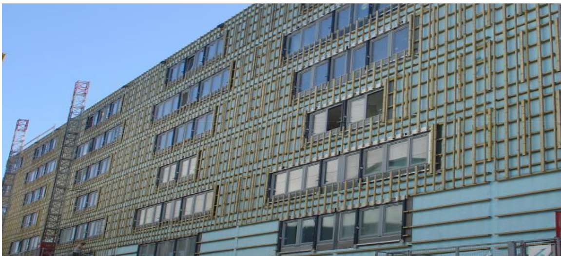
dubbel houten achterconstructie
