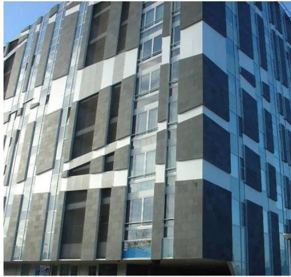
appartementen Gelderlandplein, Amsterdam (Braziliaanse leisteen)
